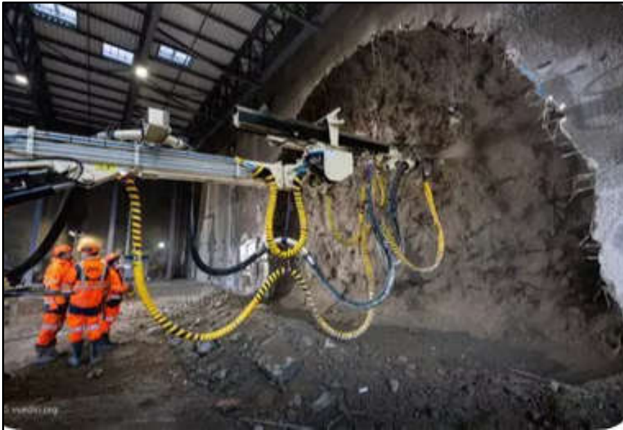
Creusement traditionnel au wagon-drill avec emploi d'explosif
