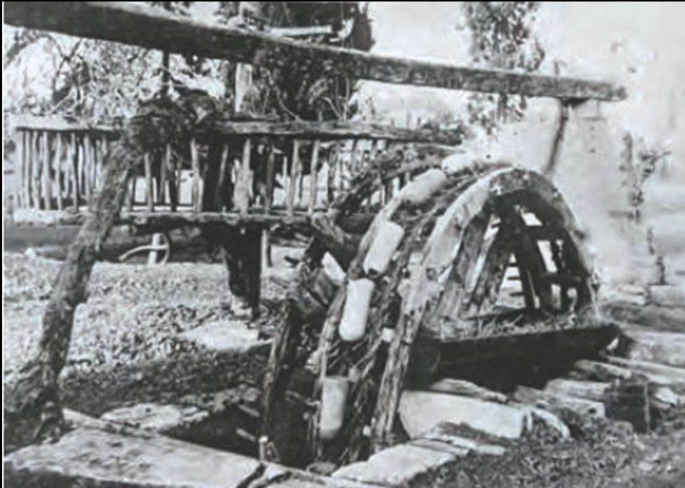
Kition-Bamboula (Chypre), puits à roue élévatrice du III e s. ap. J.-C.
