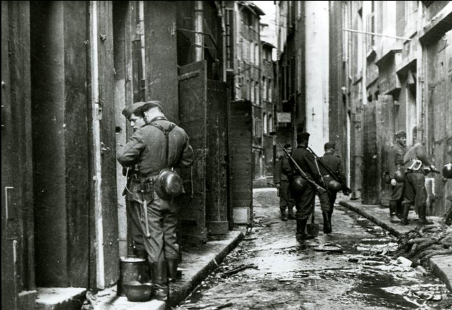
Préparation du dynamitage
